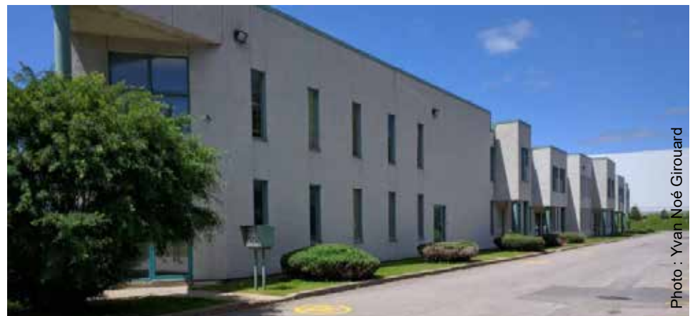
Les bureaux de l'AMECQ à Boisbriand.
